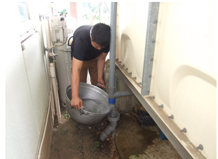
災害に備え貯水槽から直接水を使用しました
